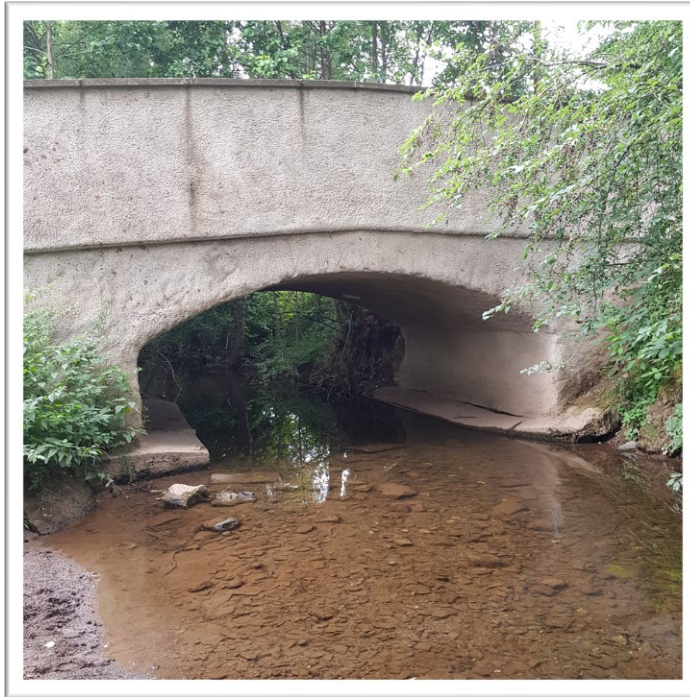
Abbildung 49 Brücke in Seimerich Quelle: P.Bratsch
