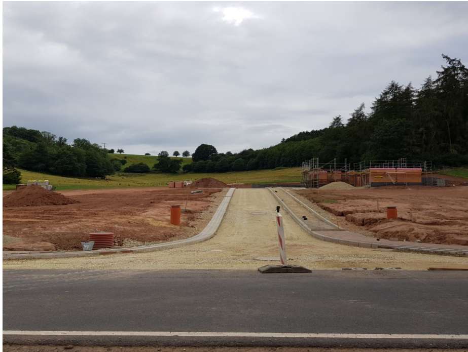
Abbildung 50 Privat erschlossenes Neubaugebiet „In Haaresdell“ Quelle: P.Bratsch
