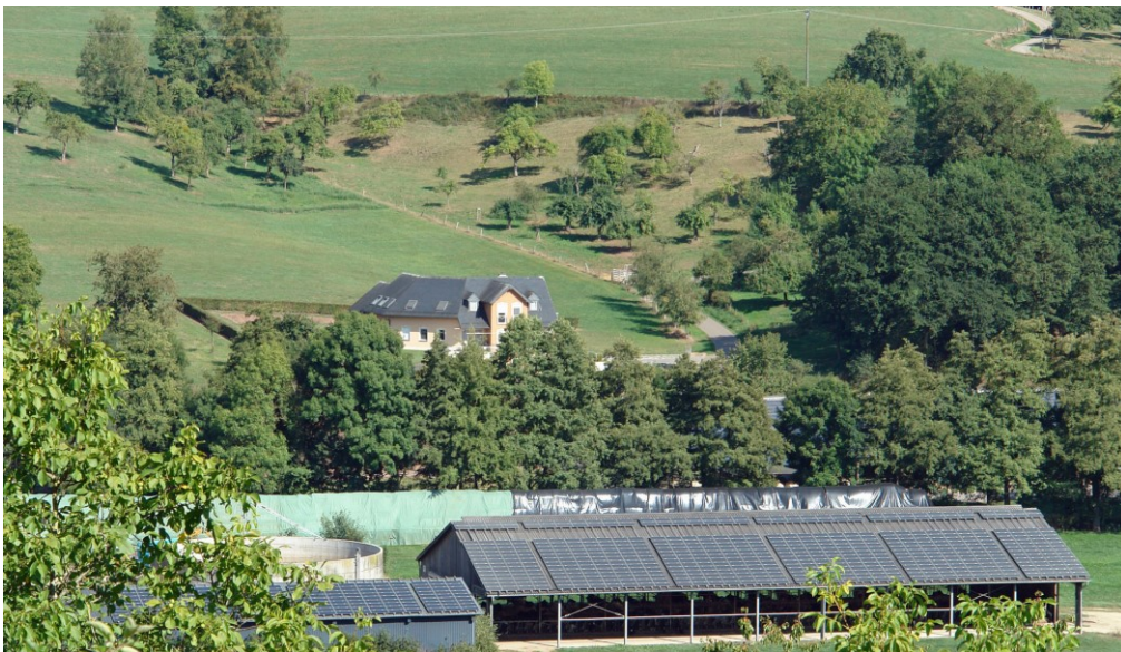
Abbildung 31 Photovoltaikanlage auf einem Stall Quelle: ortsgemeinde-koerperich.de
